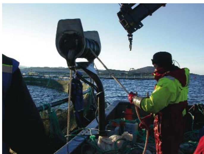
Fire blytau må til for å strekke ut presenningen. Disse legges ut under nota.
